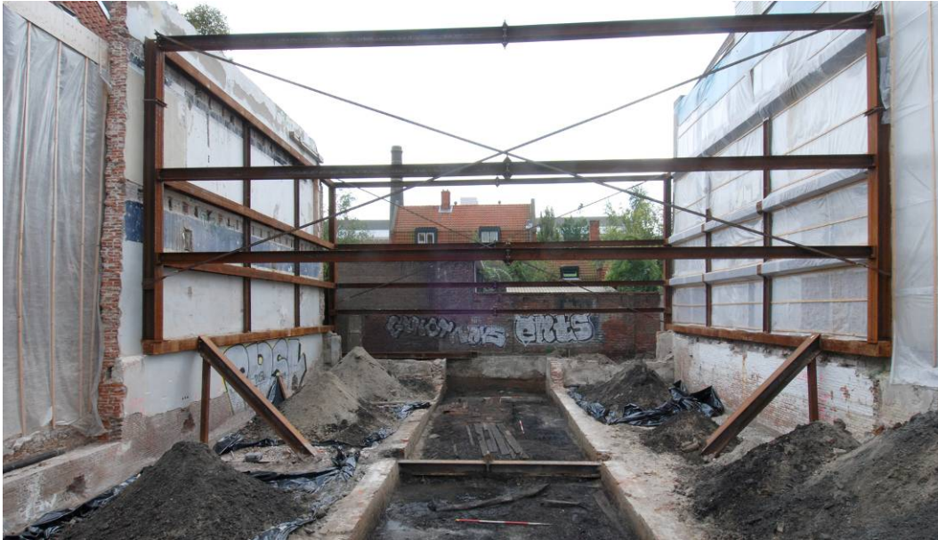
21 De opgegraven fundering van pakhuis De Koorndrager op het middelste perceel 75 en het deels nog bewaard gebleven, en gestutte, opgaande werk van dit 17de-eeuwse gebouw
